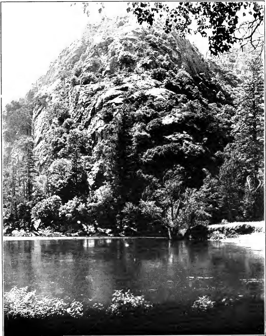
HETCH HETCHY DAM SITE
